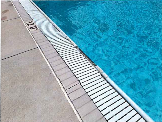
21. BROKEN GUTTER BULLNOSE
